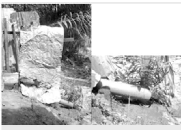
Figure 11 - Evacuation d'une latrine directement dans l'environnement, à proximité d'un puits. Le médaillon détaille le tuyau d'évacuation.
