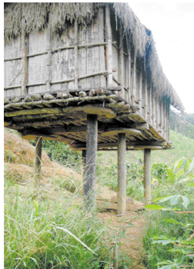
Figure 3 - Grenier traditionnel à Madagascar. Noter les pilotis et les disques de bois gênant le passage des rongeurs du sol vers la pièce de stockage (© J.B. Duchemin, Institut Pasteur de Madagascar).
