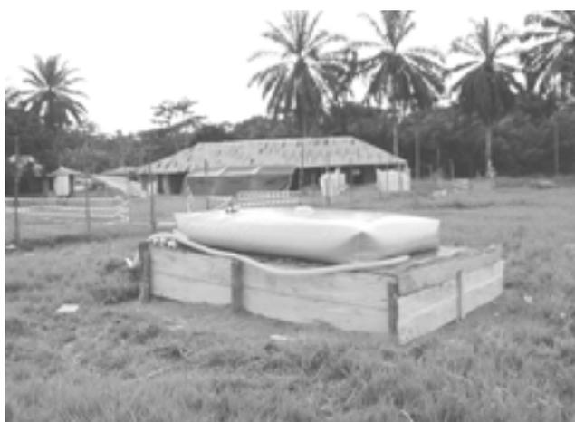
Figure 1 - Hôpital de Mekambo (département de la Zadié, province de l'Ogooué-Ivindo, Gabon). Installation d'une zone d'isolement avec adduction d'eau pour les patients suspects d'infection par le virus Ebola.
